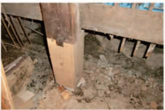
使える柱を根継ぎして補強。京都市から町家+耐震改修の助成金(※1)を受け、安心・安全な構造に。
