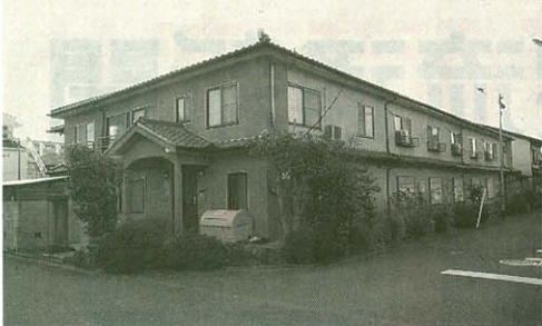
学生寮として再生した木賃アパート
