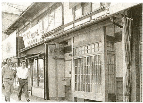
不動産業者が改装し、滞在型観光客らに短期で貸し出していた町家（京都市北区北大路通堀川西入ル）
